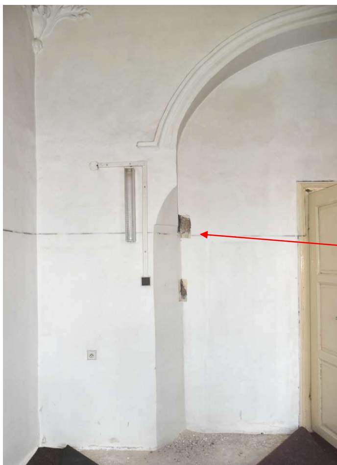
Sokolov, zámek - patro, severní křídlo, sál se štukovým stropem 247 detail sekundární dozdivky původně volného otvoru
