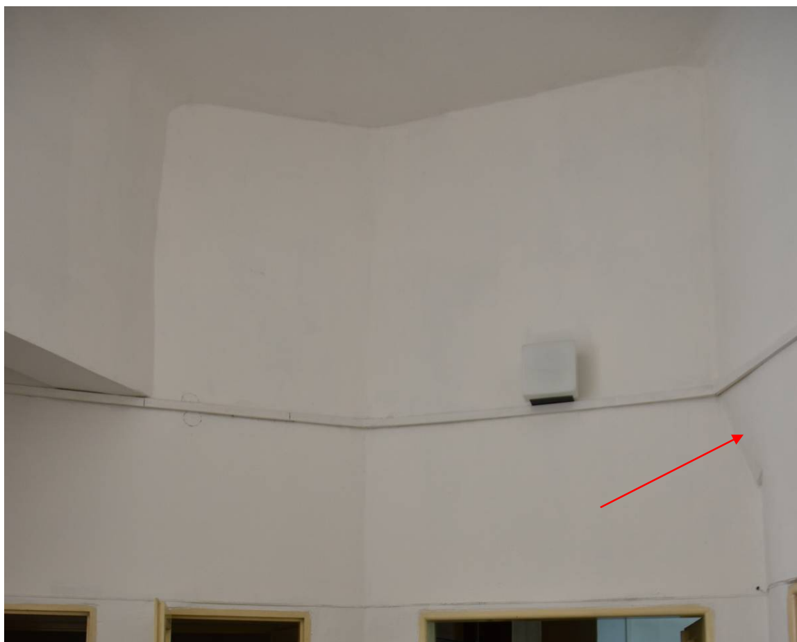
Sokolov, zámek - patro, východní křídlo, vstupní prostor před kaplí detail náběhu původního zaklenutí
