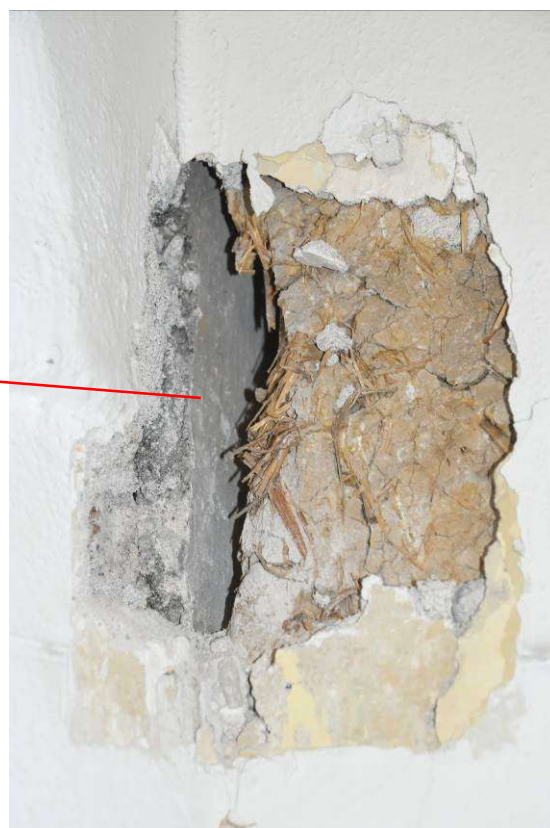
Sokolov, zámek - patro, severní křídlo, sál se štukovým stropem 247 detail sekundární dozdivky původně volného otvoru
