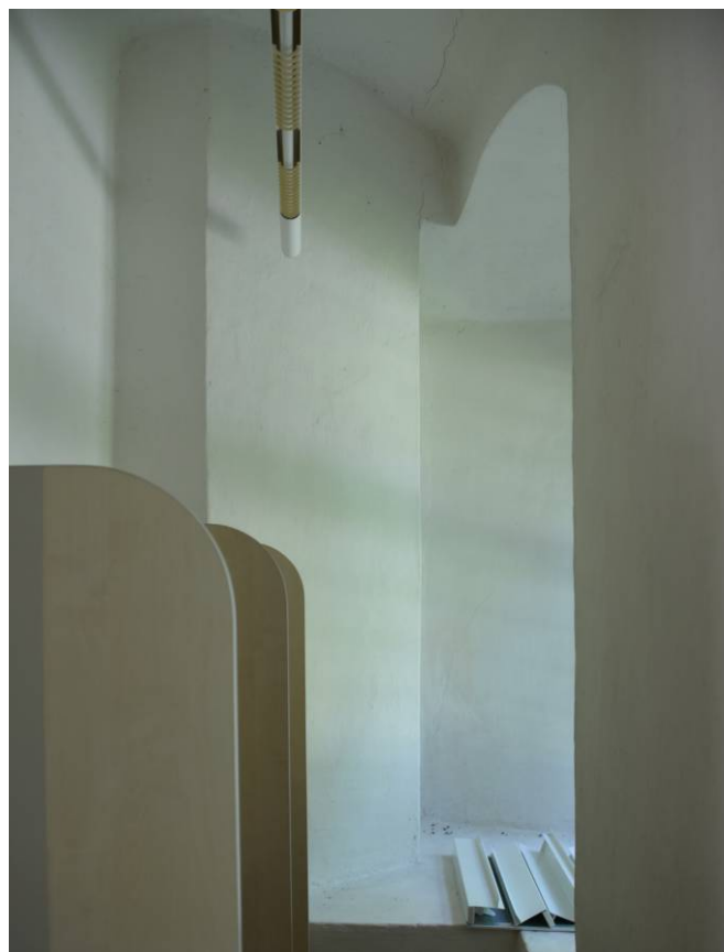
Sokolov, zámek - přízemí, východní křídlo, místnost 137 za sálem s arkádami původní průchod s okosenou špaletou (?)
