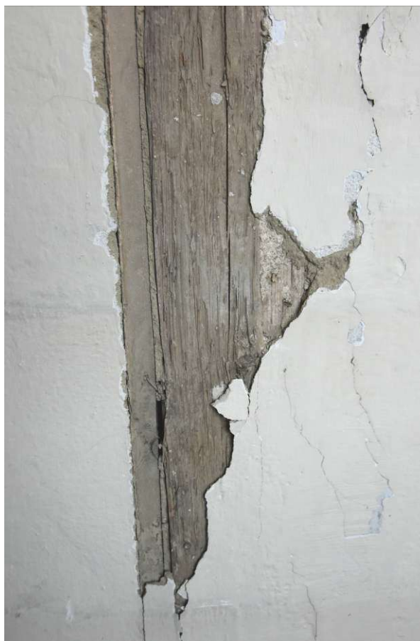
Sokolov, zámek - patro, severní křídlo, detail dřevěné zárubně zazděného průchodu do m. 251
