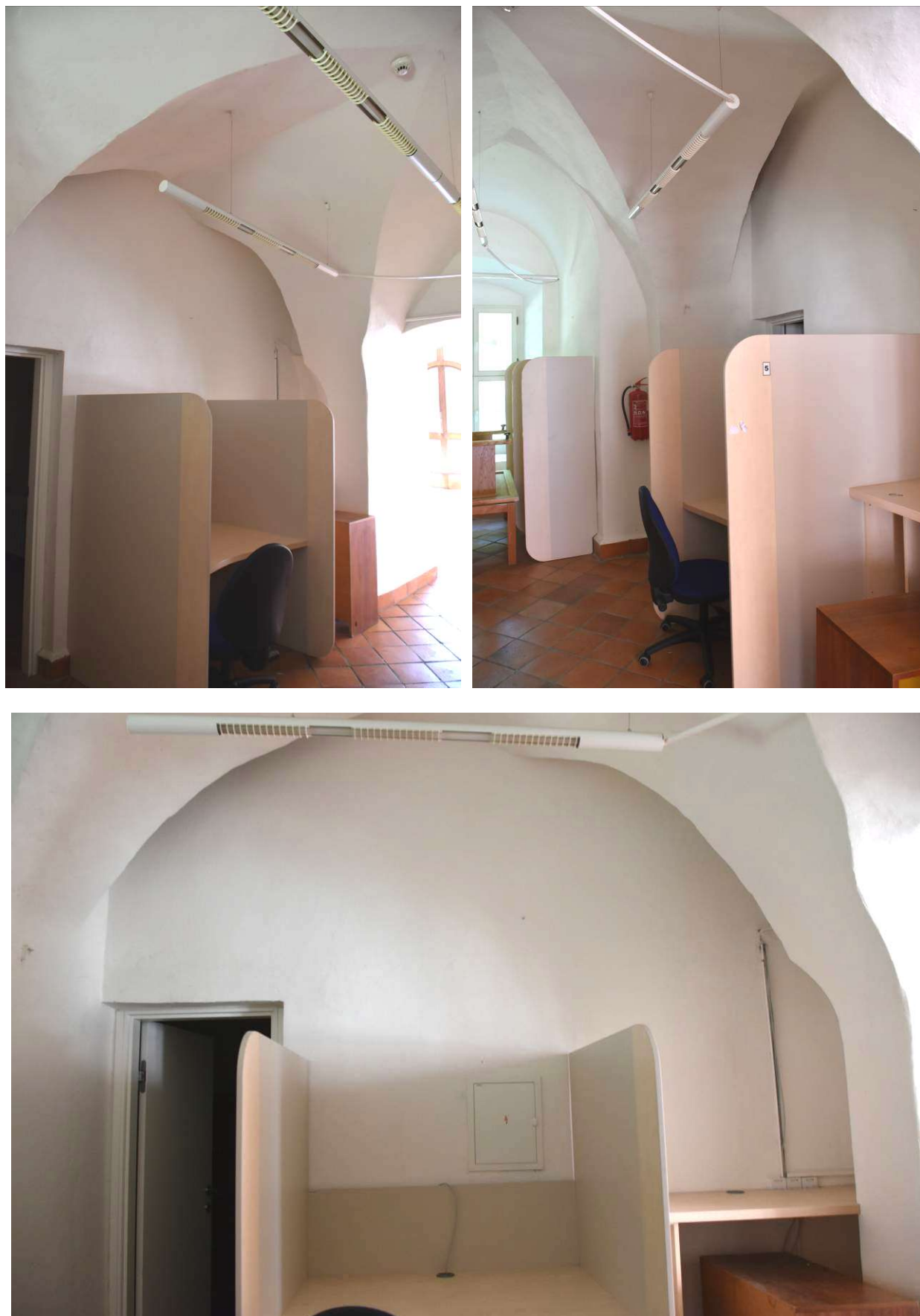
Sokolov, zámek - přízemí, východní křídlo, místnost 137 za sálem s arkádami sekundární dozdivka v průběhu valené klenby
