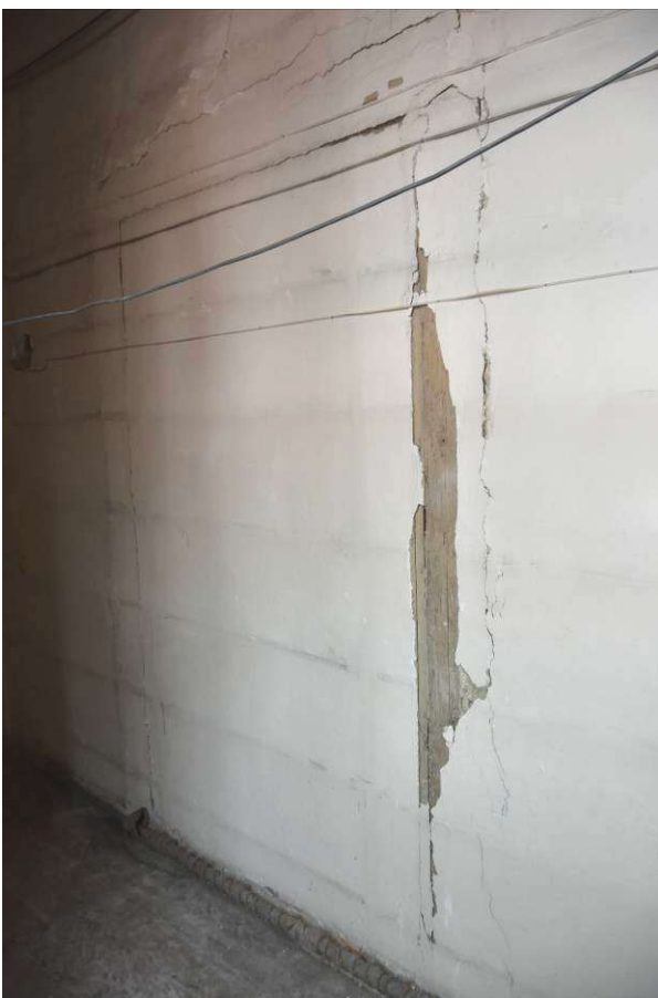
Sokolov, zámek - patro, severní křídlo, detail dřevěné zárubně zazděného průchodu do m. 251
